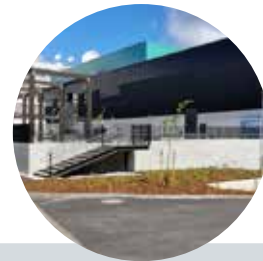
Digita Data Center 2
