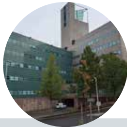
Digita Data Center 1
